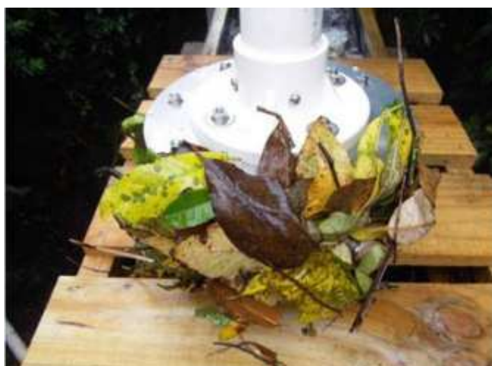
ガイドベーン口にたまった枯葉が水の流入を邪魔している状態。手で常に掃除の必要(LH)
