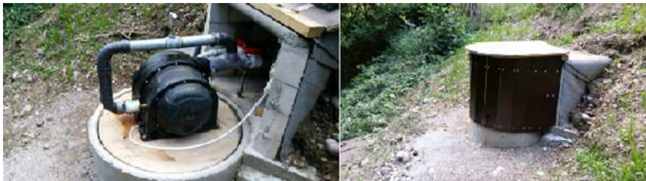
騒音対策を施し、環境に配慮した例です(PLT)
