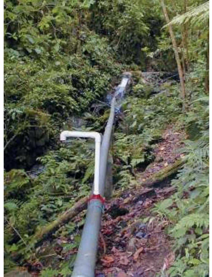
取水口側（上側）と水圧管の設置例（白い管は脱気管です）
