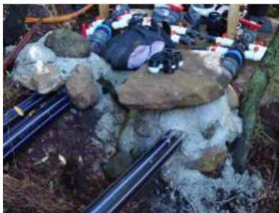
発電機手前の導水管の固定状況（セメントや岩石で発電機手前の導水管の安定を計る）
