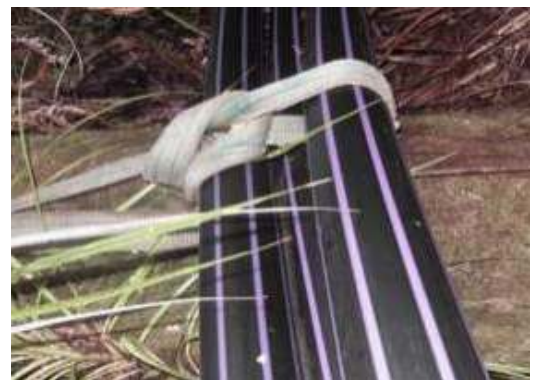
導水管の中間固定の様子（仮設置中）
