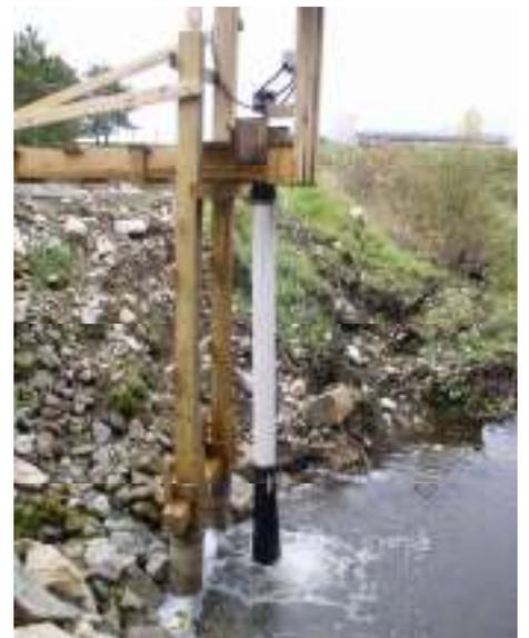
排水溝水面への排水管排水口の浸水間隔：50mm以上
