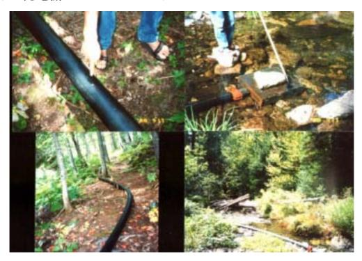
空気抜穴が一番高度の高い場所に空けられ、水源の金網の水コケ清掃。2kM のパイプラインで発電機に水を供給。
