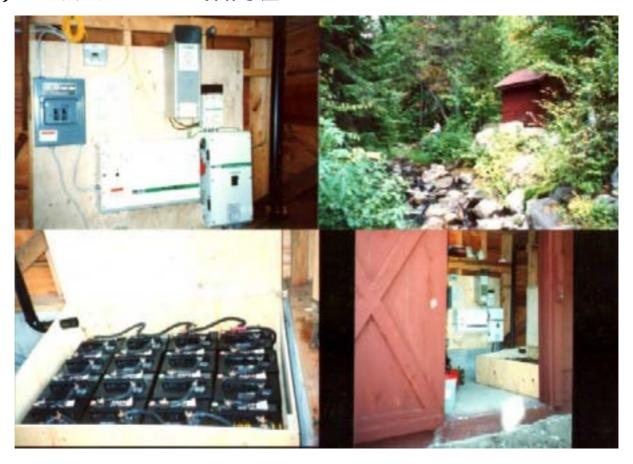
上写真::電気を貯蔵しAC変換で電力利用。電力会社のサービスがこない場所での知恵。 Sussex から車で3時間で発電した電気の貯蔵小屋に到着。電池群、インバーター、操作スイッチ、余剰電力のヒーターボックスが見えます。
